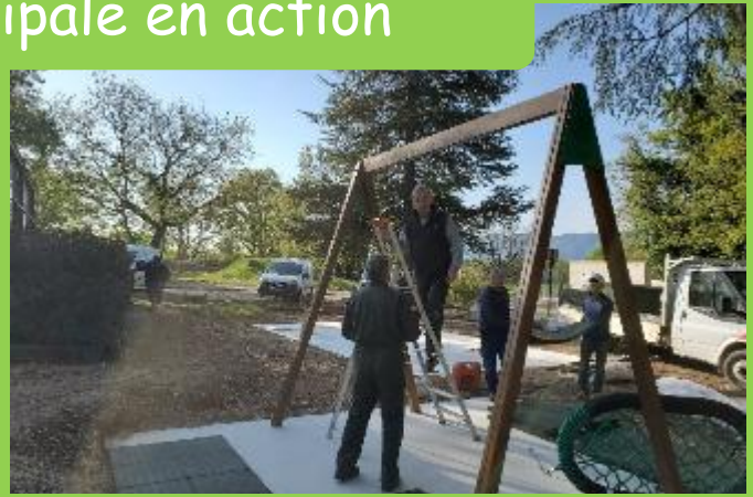
Montage de la 1ere structure
